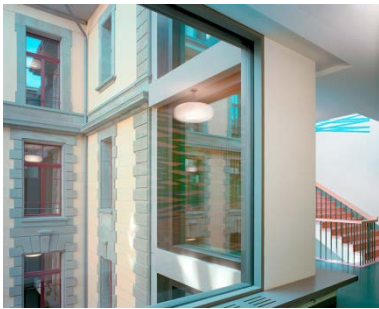
Bild 6: Schulhaus Viktoria (Viktoriastrasse 71) nach Sanierung und Erweiterung 2007 - 2011, Übergang von Alt- und Neubau. Foto: Walter Mair, Zürich
