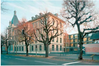
Bild 5: Schulhaus Viktoria (Viktoriastrasse 71) nach Sanierung und Erweiterung 2007 - 2011, Aussenansicht. Foto: Walter Mair, Zürich
