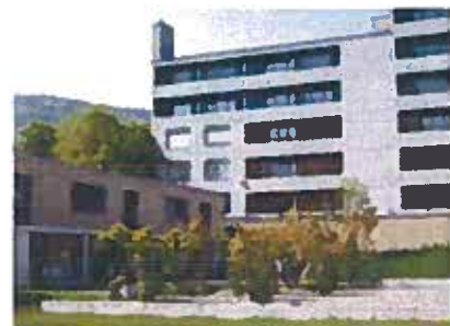
Kindergarten und Wohnblock
