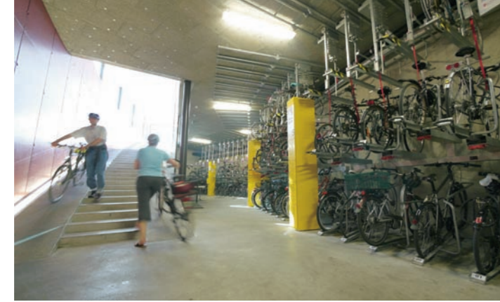
Velostation Milchgässli mit 500 sicheren und gedeckten Veloabstellplätzen.
