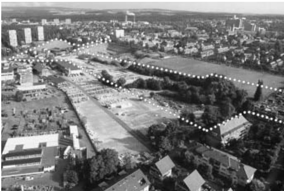
Flugaufnahme des Planungsgebiets (innerhalb der punktierten Linie): Unten rechts das Grenzwegquartier der Gemeinde Köniz, oben links der Könizbergwald mit den drei Hochhäusern, rechts die Eisenbahnersiedlung.
