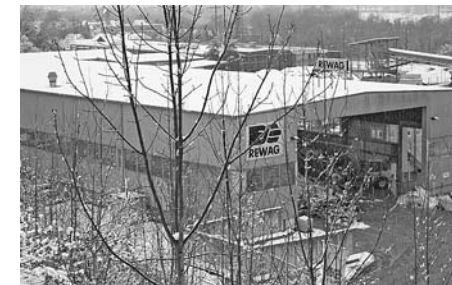
Vorbildliche Recyclinganlage in Kaiseraugst
