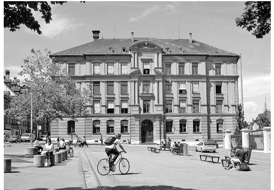
Ehemaliges Progymnasium am Waisenhausplatz 30
