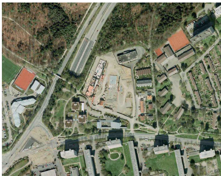
Orthofoto der Baustelle WestPark 2008
