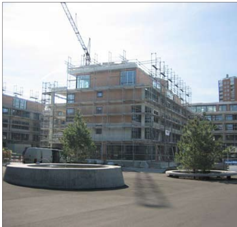
Bild 8: Baustelle der Überbauung «all in one»
