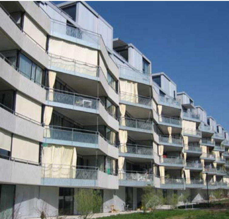
Bild 3: Überbauung Hardegg, Langhaus
