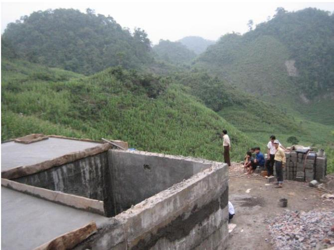
Das Betonreservoir ist in Kammern aufgeteilt, welche das Wasser filtern. (Foto: Caritas Schweiz)
