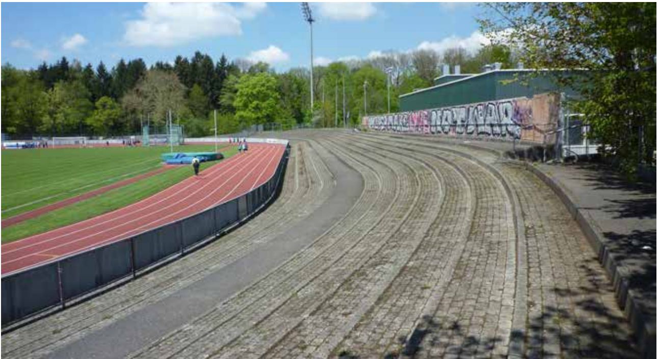
Neufeld Stadion: Bestand Stehrampe
