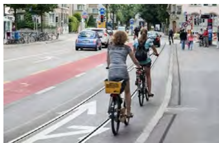
Balanceakt: Die schmale Durchfahrt zwischen Gleis und hoher Haltekante erfordert Geschick und schliesst weniger geübte Velofahrende aus. Mit Anhängern und Cargobikes sind solche Haltestellen äusserst schwierig zu durchfahren.
