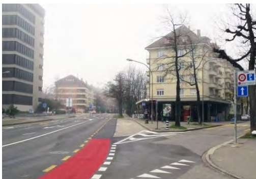
Haltestelle Schönburg: Busbucht mit durchgehendem Radstreifen
