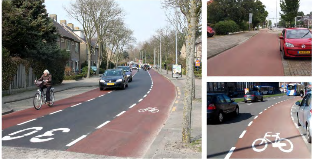
Kernfahrbahn mit breiten Rastreifen und schmalen Kern. Die farbliche Gestaltung der Radstreifen vermittelt intuitiv und wahrnehmbar, dass der Veloverkehr auf dieser Strasse präsent ist.
