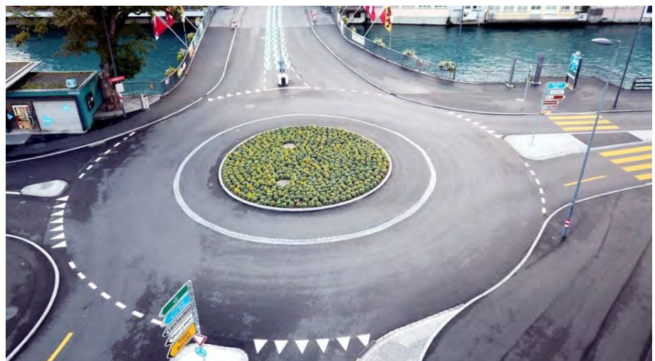
Kreisverkehr mit rund 26 m Durchmesser und baulich abgesetztem Innenring, welcher die Geschwindigkeit bremst.
