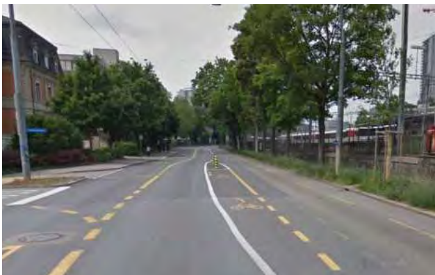
Abbiegehilfe nur für den Veloverkehr (Laupenstrasse)
