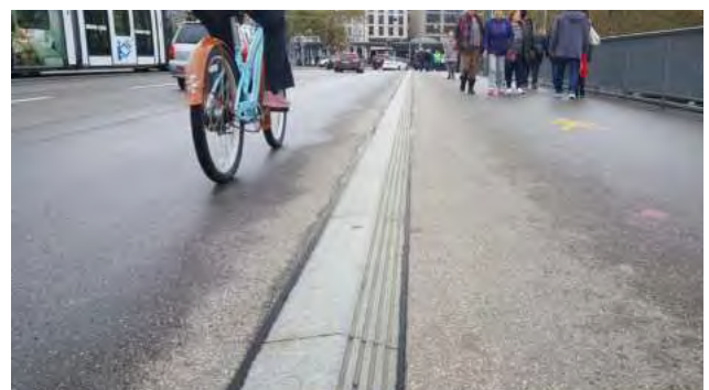
Trennung Fuss- und Veloverkehr Quaibrücke, Zürich
