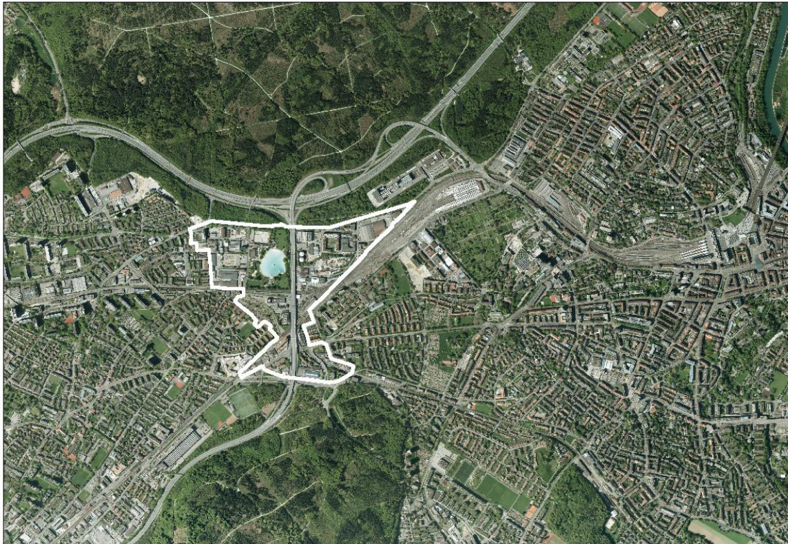
Perimeter und Lage des ESP Ausserholligen: Das Gebiet reicht vom Areal Weyermannshaus West im Westen bis zur Bahnlinie im Osten und von der Murtenstrasse im Norden bis zum Könizbergwald im Süden
