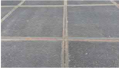
Betonplatten, mit sickerfähigen Fugen
