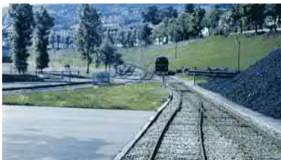
Gasbahngleise in Richtung Wabern
