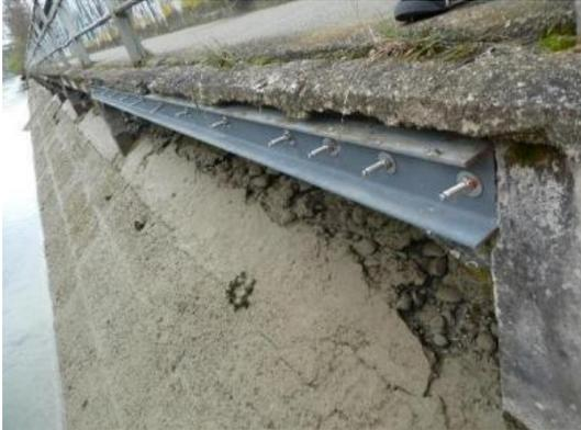
Abb. 3: Sicherung der Gehweg-Lehenkonstruktion
