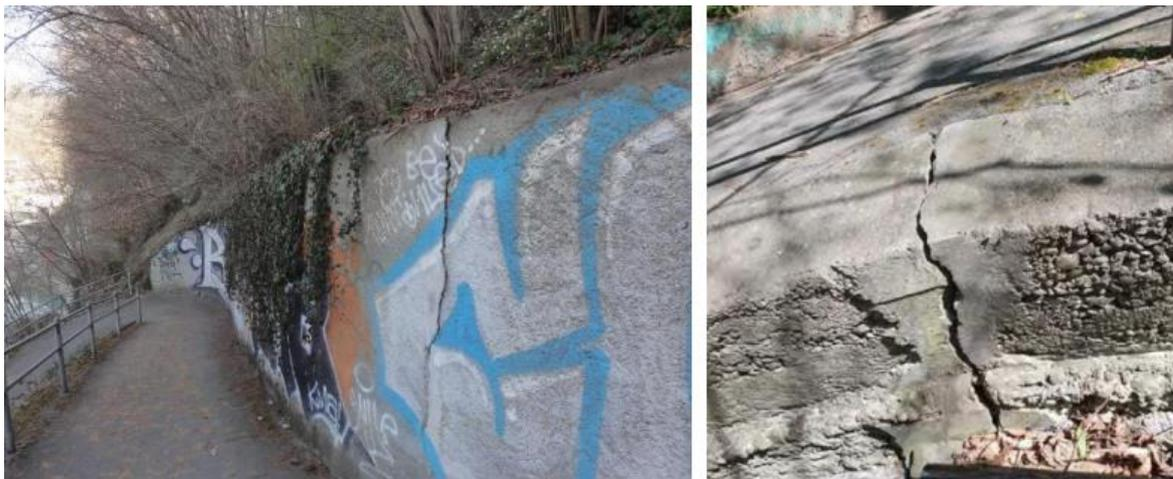
Abb. 15: Stützmauern mit Verschiebungen und Rissen
