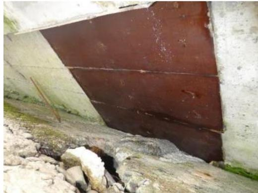
Abb. 4: Verstärkungen im Bereich von Korrosionsschäden
