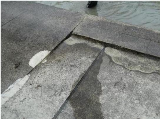
Abb. 6: Stolpergefahr bei Zugang Becken
