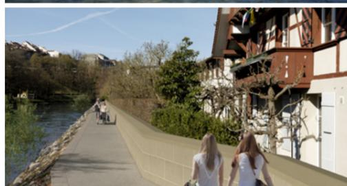
Im Altenbergquartier wird eine neue Ufermauer gebaut, die während einer Gefahrenlage mit mobi- len Elementen erhöht werden kann. Der Fussweg entlang der Aare wird verbreitert.
