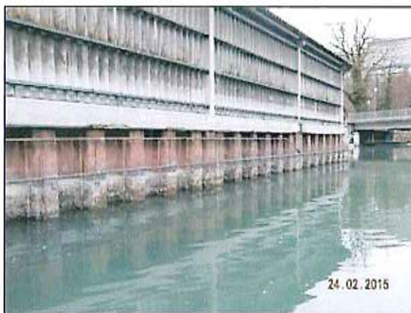
Foto 2810: Abschlusswand Übersichtsfoto Aussen mit Spundwand, oberem Abschluss mit Betonbalken und Überdachung.
