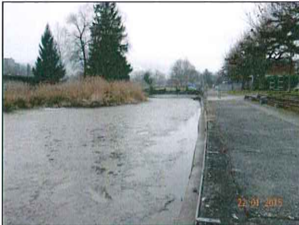
Grosse Schlammablagerungen im Bueberseeli
