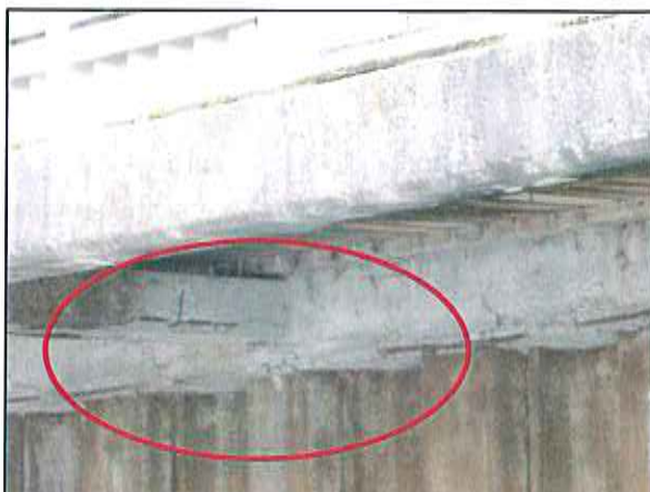
Querträger Steg, Balken Spundwand 2009:
