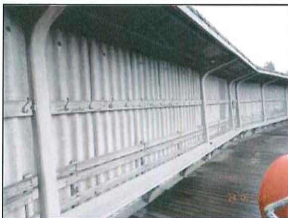
Foto 356: Stegkonstruktion, Überdachung Die Überdachung mit Eternitplatten weist nur vereinzelte Schadstellen auf.
