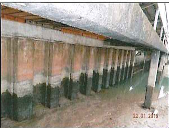
Foto 249: Abschlusswand Übersichtsfoto Innen mit Spundwand und oberem Abschluss mit Betonbalken.
