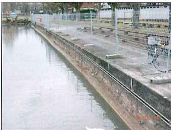
Übersicht Stützmauer entlang Bueberseeli
