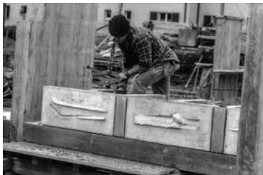
... die Platten werden eingebaut, 1993/94
