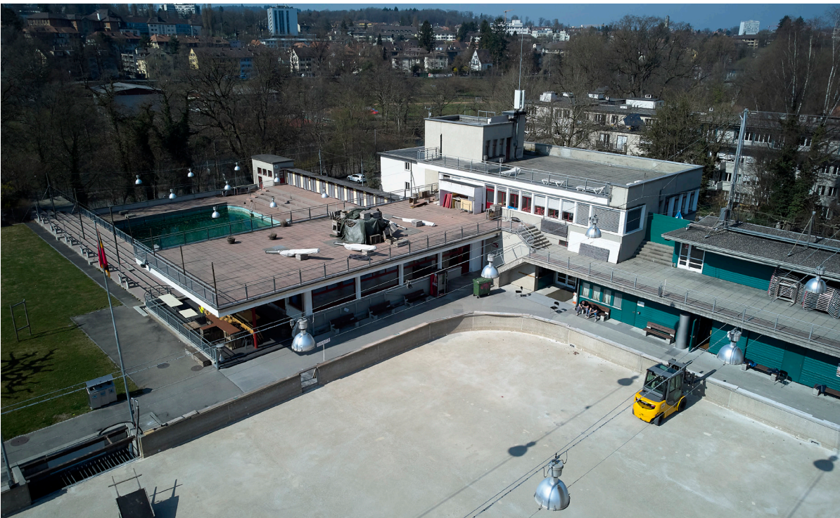
Luftaufnahme Hauptgebäude von Osten
