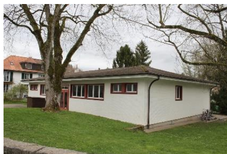
Schulpavillon II an der Forrerstrasse 3
