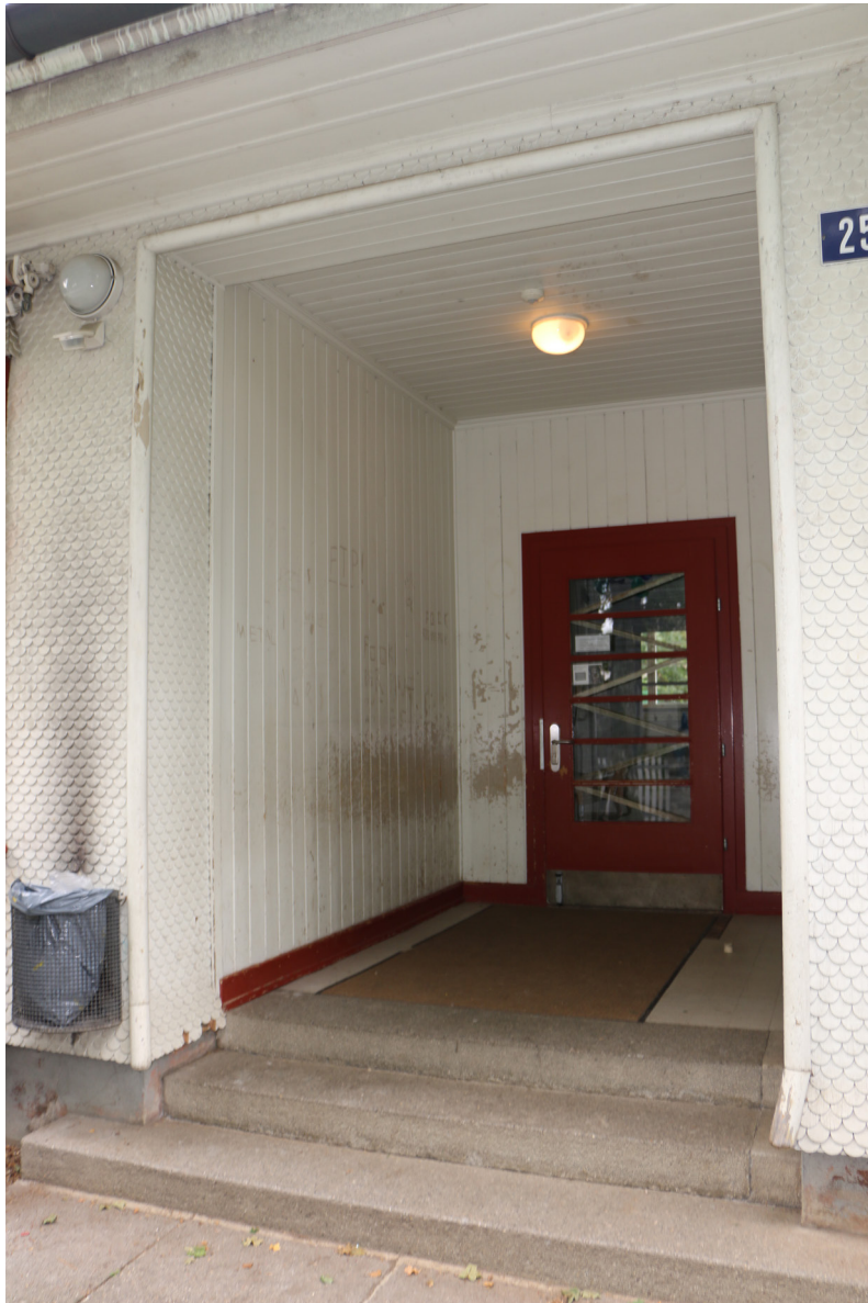
Eingangsbereich Schulpavillon I
