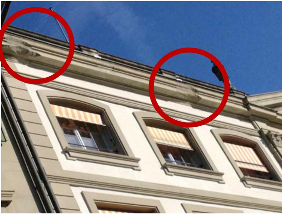
Südfassade mit abgebrochenem Dachgesims (rot)
