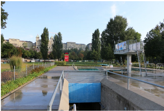
Abb. 5. Sprungturm und Eingang zum Technikraum
