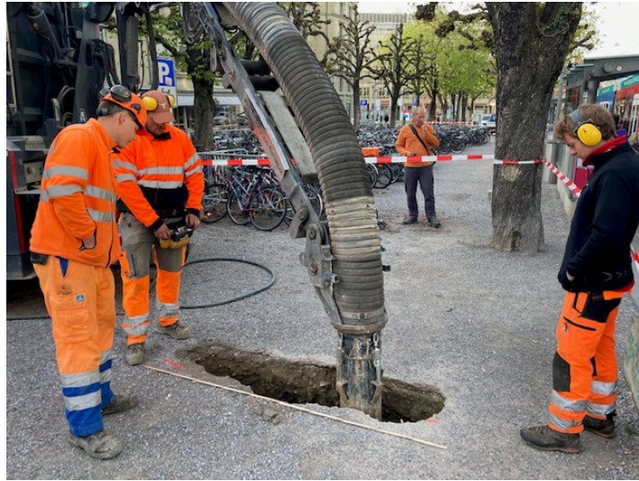
Sondierung 1 – entlang geplanter Abgrabung für den Treppen- und Liftaufgang
