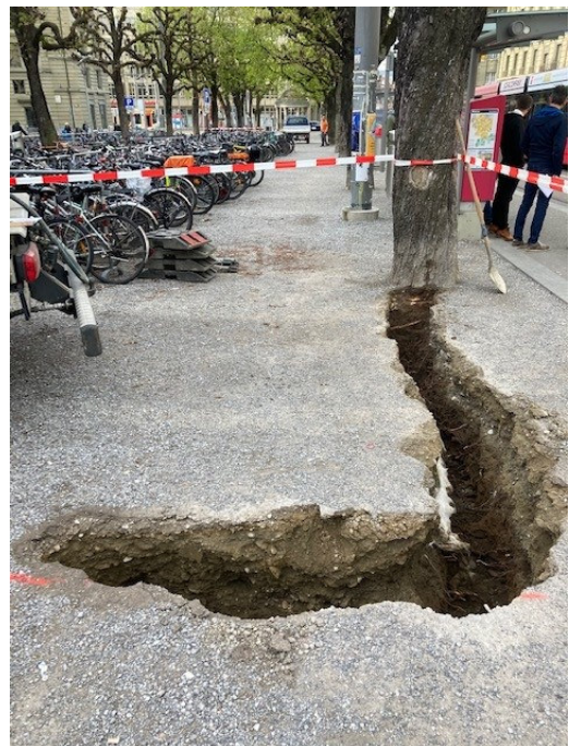
Bodenauftrag am Stammfuss 7 cm und in einer Entfernung von 4.5 m ab Stammmitte 40 cm
