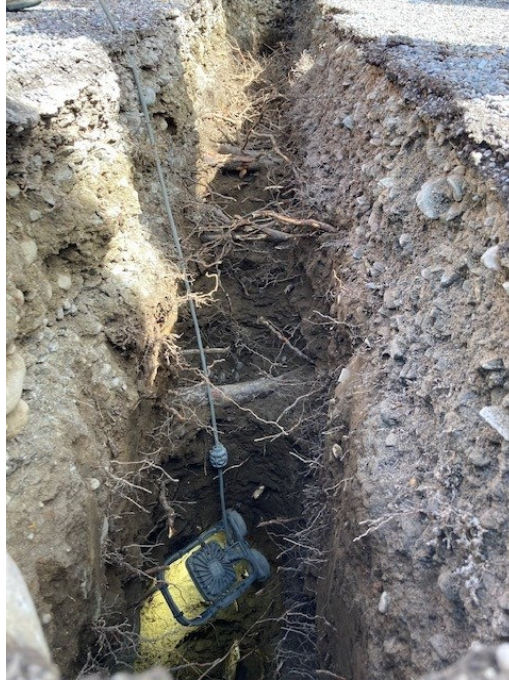
Starke Durchwurzelung ab einer Tiefe von 30 cm bis in eine Tiefe von mindestens 160 cm
