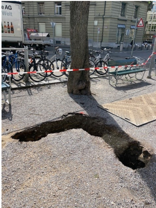
Sondierung 3 – neuer Standort Bubenberg-Denkmal Süd-Ost
