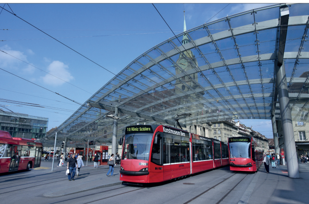
Unterwegs vom Bahnhof Bern Richtung Köniz-Schlieren: Tram der künftigen Linie 10 bei der Abfahrt beim Baldachin.
