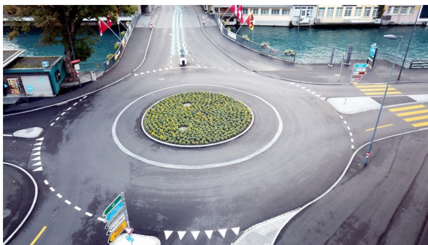
Kreisverkehr mit rund 26 m Durchmesser und baulich abgesetztem Innenring, welcher die Geschwindigkeit bremst.
