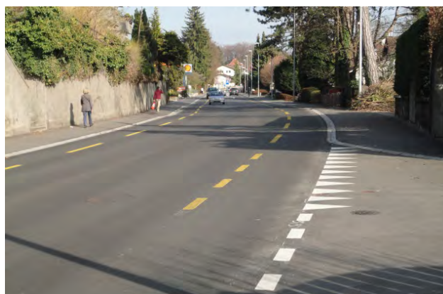
Ortsdurchfahrt Muri bei Bern. Auf der rund 8 m breiten Strasse wechseln sich Radstreifen und Mittelinseln für den Fussverkehr ab. Für den Veloverkehr stellt dies bei einem DTV von ca. 7'400 nicht den Idealfall dar, ist aber in Abwägung aller Interessen vertretbar.
