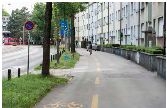
Anwendungsfall in Bern: Der Ostring im Zustand vor der Sanierung. Diese Strasse ist aufgrund der Verkehrsbelastung generell wenig geeignet, um den Veloverkehr mit Radstreifen auf der Fahrbahn zu führen. Das Unsicherheitsgefühl bliebe für viele Velofahrende zu hoch.
