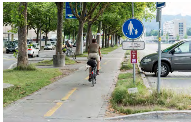
Entlang der Papiermühlestrasse ist es für den Veloverkehr zugelassen, den Fussweg zu benützen. Damit kann die stark belastete Strasse sowie die Kaphaltestelle umfahren werden. Die Ausführung entspricht nicht den Vorgaben des UHR (taktile Abgrenzung FG / Velo fehlt).
