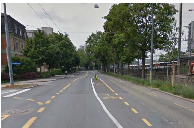
Abbiegehilfe nur für den Veloverkehr (Laupenstrasse)
