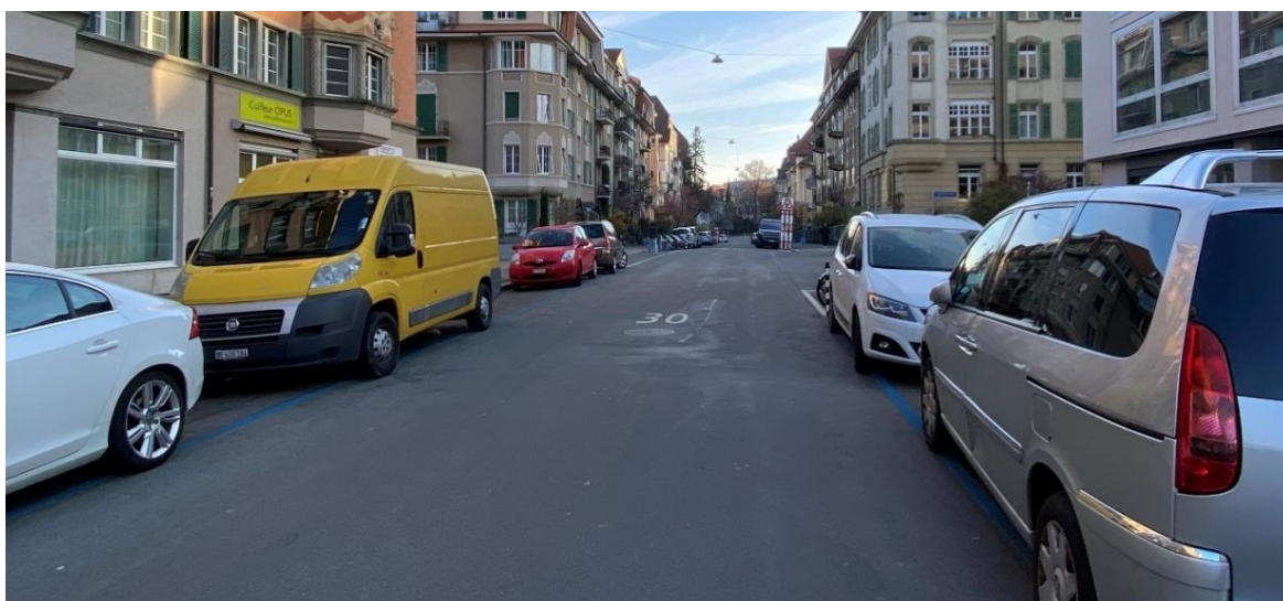
Abb. 3: Ist-Zustand Optingenstrasse (Fassade zu Fassade = 15m, Strassenbreite = 8m)
