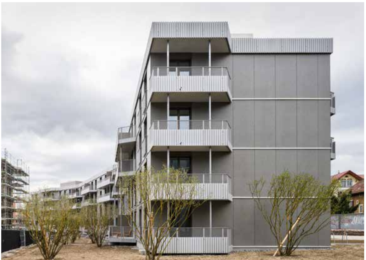
Fassaden Haus C
