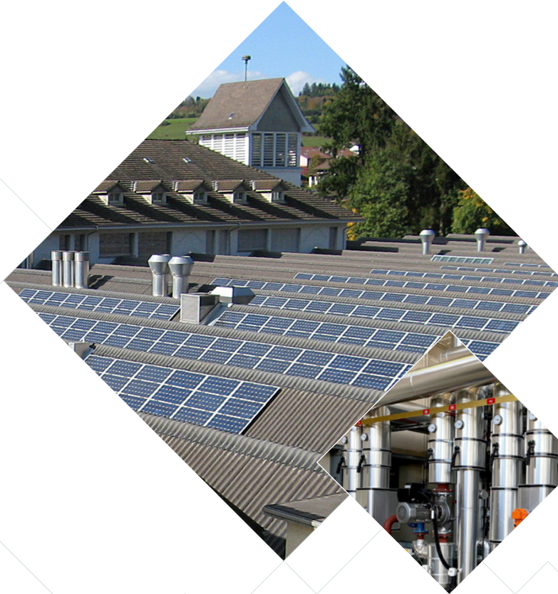
Technische Anlagen Gewerbepark Felsenau
