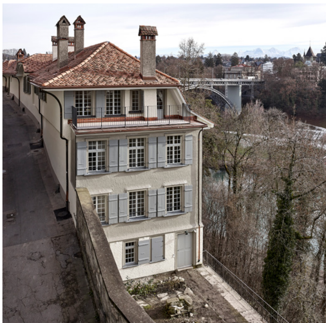
Münzrain und Westfassade Bondel- haus mit neu angebauter Terrasse
