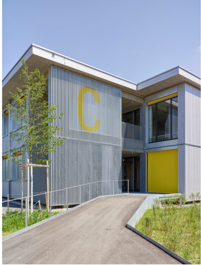
Aussenansicht Schulmodulbau C
