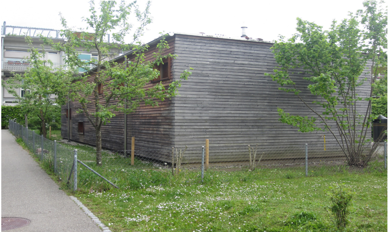
Fassade des bestehenden Kindergartens
