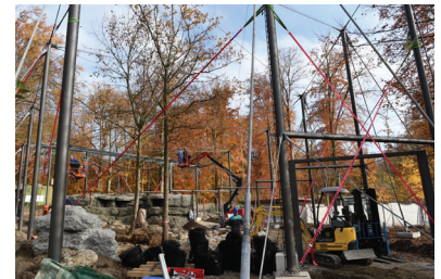
Bau der Eulen Voliere
