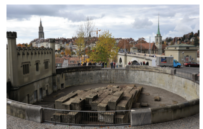
Grosser Bärengraben nach der Sanierung
