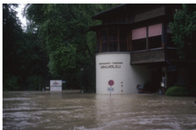
Hochwasser vom Mai 1999
