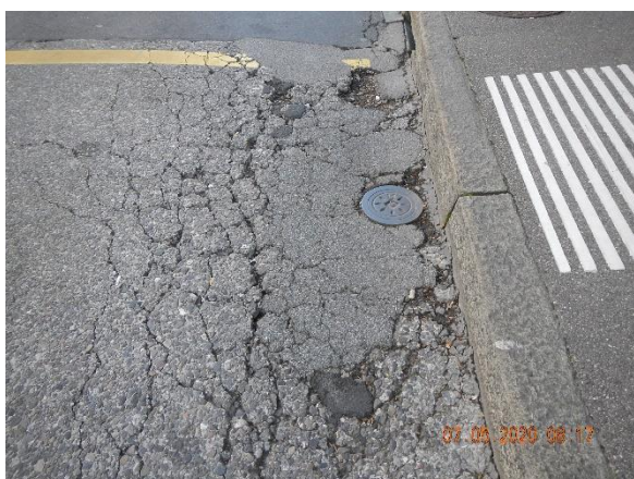
Abbildungen 1-4: Bilder des schadhaften Belags auf der Länggassstrasse
