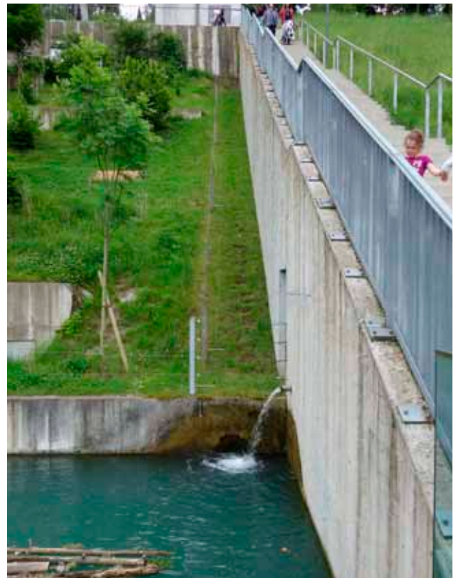
Stützmauer Süd vom Uferweg gesehen
