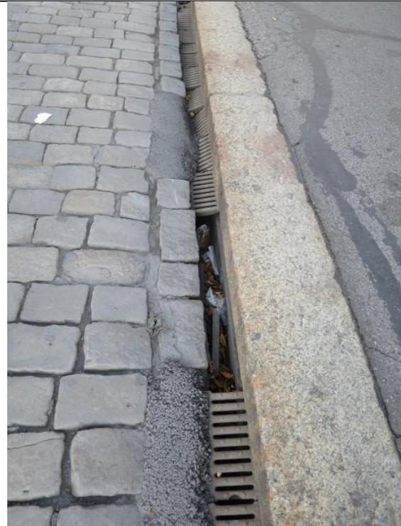
Abb. 8: Entwässerungsrinnen grösstenteils defekt (Instandstellung geplant in Etappe 1)
