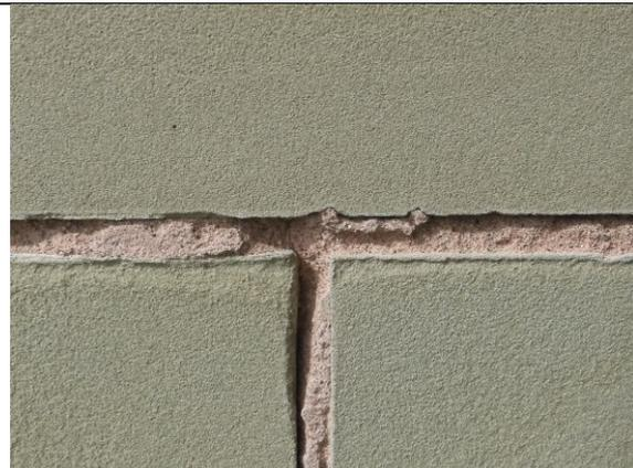
Abb. 11: Ausgewitterte Mörtelfuge (Instandstellung geplant in Etappe 2)
