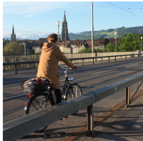
Kornhausbrücke in Bern
