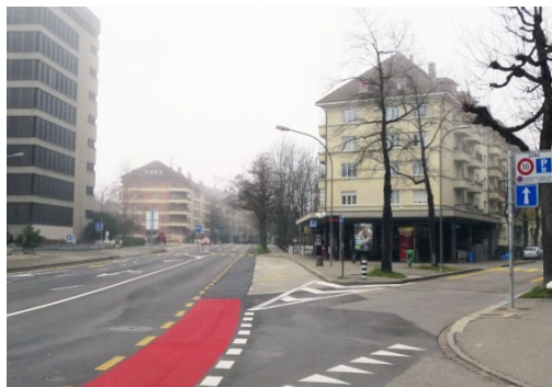
Haltestelle Schönburg: Busbucht mit durchgehendem Radstreifen.
