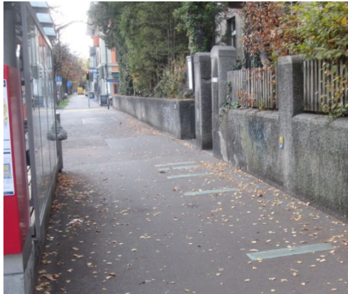
Rüttelstreifen auf dem Trottoir (Velo gestattet) entlang der Thunstrasse in Bern. Die Fahrlinie des Veloverkehrs wird damit beeinflusst (Wirkung jedoch gering aufgrund des niedrigen Versatzes). Die Veloführung wird im abgebildeten Abschnitt im Rahmen des Projekts Gesamtanierung Thunstrasse / Ostring geändert (strassenbegleitender Radweg).
