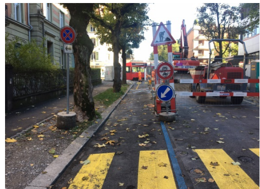
Trotz grossen Baumassnahmen wird die Durchfahrt für den Veloverkehr ermöglicht. Am Rand der Baustelle konnte eine schmale Durchfahrt für den Veloverkehr offen gehalten werden. Damit werden neben der Durchgängigkeit für den Veloverkehr auch Konflikte mit dem Fussverkehr auf dem Trottoir vermieden (Spitalackerstrasse).
