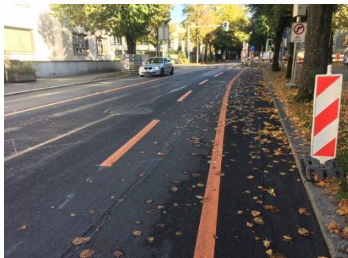
Gute und klare Veloführung vor der Querschnittsverengung. Im anschliessenden Bereich der Baustelle konnte trotz engem Querschnitt ein temporärer Radstreifen markiert werden (Viktoriastrasse).
