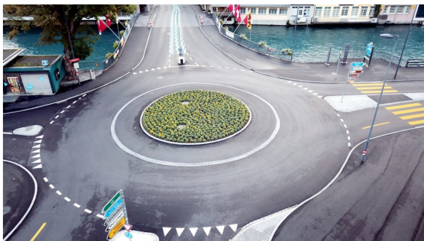
Kreisverkehr mit rund 26 m Durchmesser und baulich abgesetztem Innenring.
