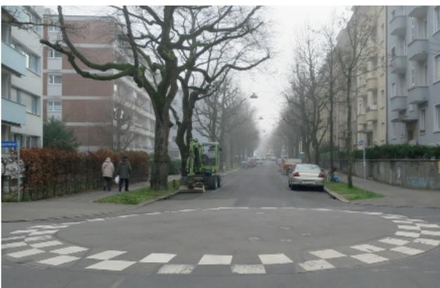
Wo zu hohe Geschwindigkeiten des MIV vorherrschen, können unterstützend Vertikalversätze eingesetzt werden. Die kreisrunde Aufsichtung füllt den ganzen Knotenbereich aus, da sie ansonsten als Kreisverkehr missverstanden werden kann.
