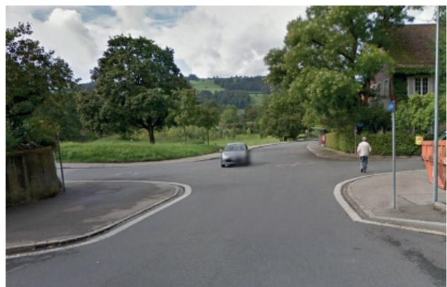
Die Verschmälerung der Durchfahrtsbreite und kleine Radien tragen zur Geschwindigkeitsreduktion des MIV und damit zur Verkehrssicherheit bei. Die Durchfahrtsbreite sollte in der Regel den Begegnungsfall MIV-Velo zulassen (mind. 4.50 m).
