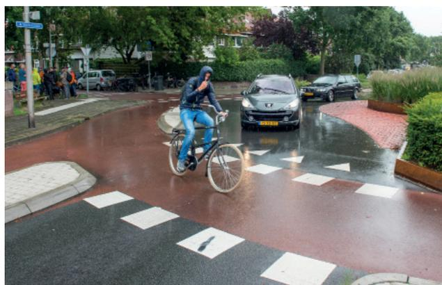
Niederländische Lösung. Der Veloverkehr wird analog zur Strecke als Radweg oder markierter Radstreifen am Kreisfahrbahnrand geführt. (Bild: Martin Rhyner).
