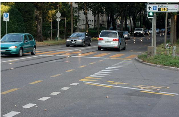
Bei starker Verkehrsbelastung durch den MIV oder bei Tramgleisen kann das indirekte Linksabbiegen als Zusatzangebot geprüft werden. Die Anlage auf der Muristrasse (Bild) weist eine bedarfs-gesteuerte Lichtsignalanlage auf.
