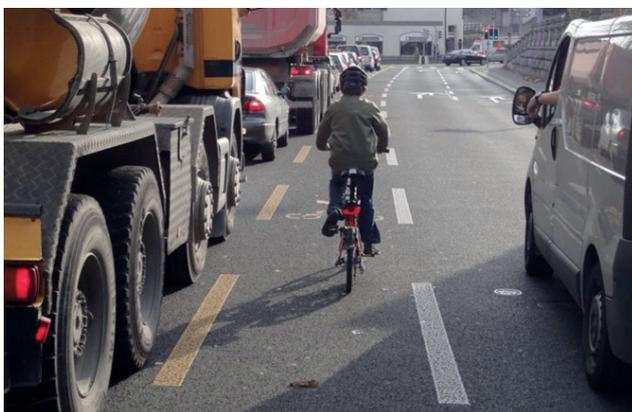
Radstreifen in der Mitte zweier Fahrstreifen des MIV sind bei mittleren und hohen Belastungen sowie bei erhöhtem Schwerverkehr- und ÖV-Anteil unangenehm (Bild: K. Zweibrücken).
