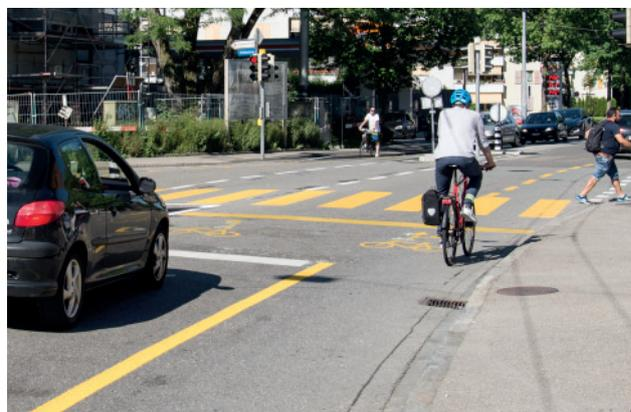
Knoten Standstrasse/Scheibenstrasse: Der aufgeweitete Radstreifen („Velosack“) ermöglicht während den Rotphasen ein Einfädeln zum Linksabbiegen. Bei Grünstart befindet sich das Velo in Sichtkontakt vor dem motorisiertem Verkehr.
