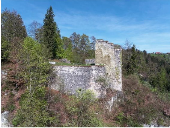
Heutiger Zustand der Vorbürg
