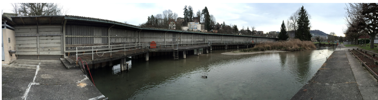
Heutiger Zustand der Anlage mit Verlandung
