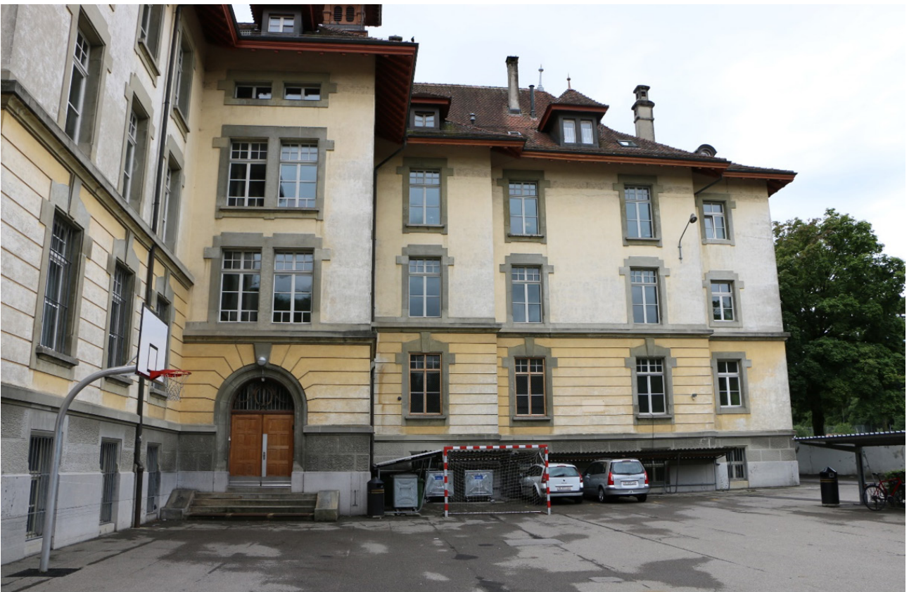
Blick aus Norden (Innenhof, Aussenraum Pausenplatz und heutiger Haupteingang)
