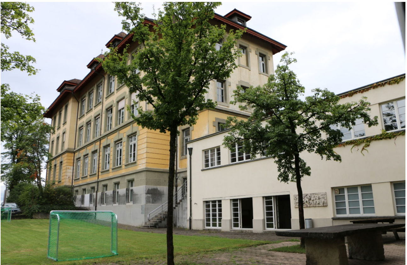
Blick aus Nordosten (Rasenfläche Turnhalle, Verbindungstrakt und Schulhaus)
