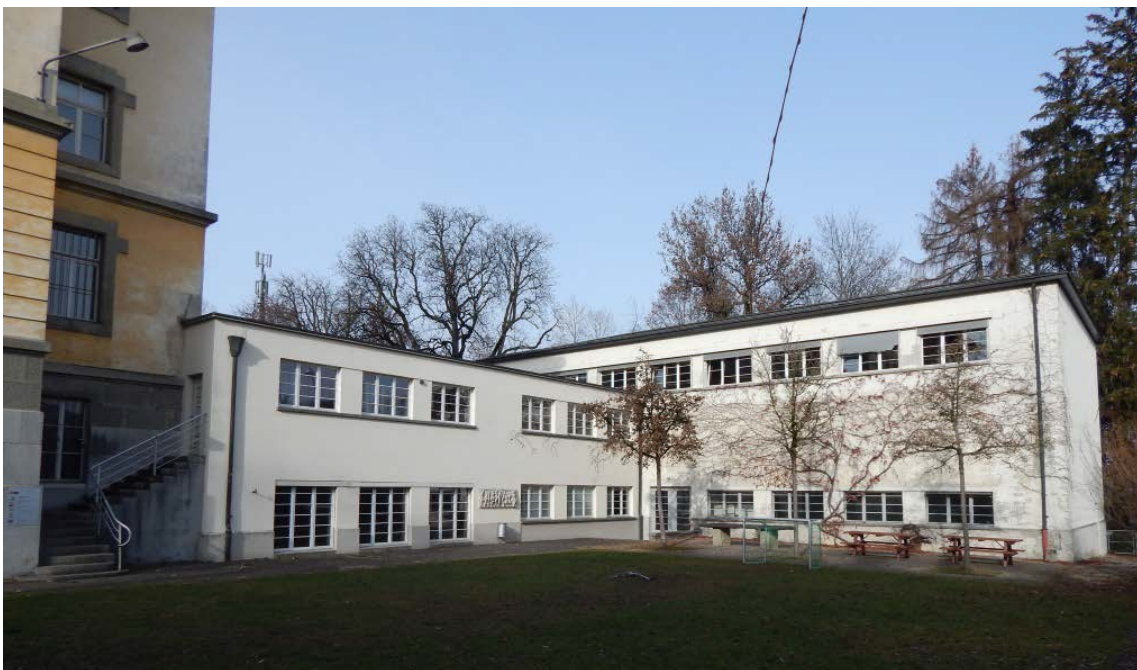
Verbindungstrakt und Turnhalle, Blick aus Südosten
