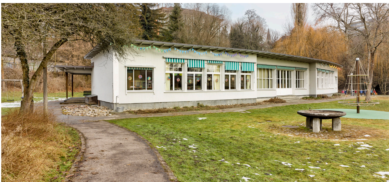
Kindergarten und Unterstufe Pavillon Brückenstrasse 70
