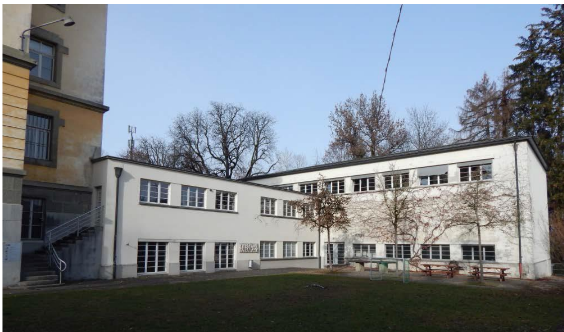
Verbindungstrakt und Turnhalle, Blick aus Südosten
