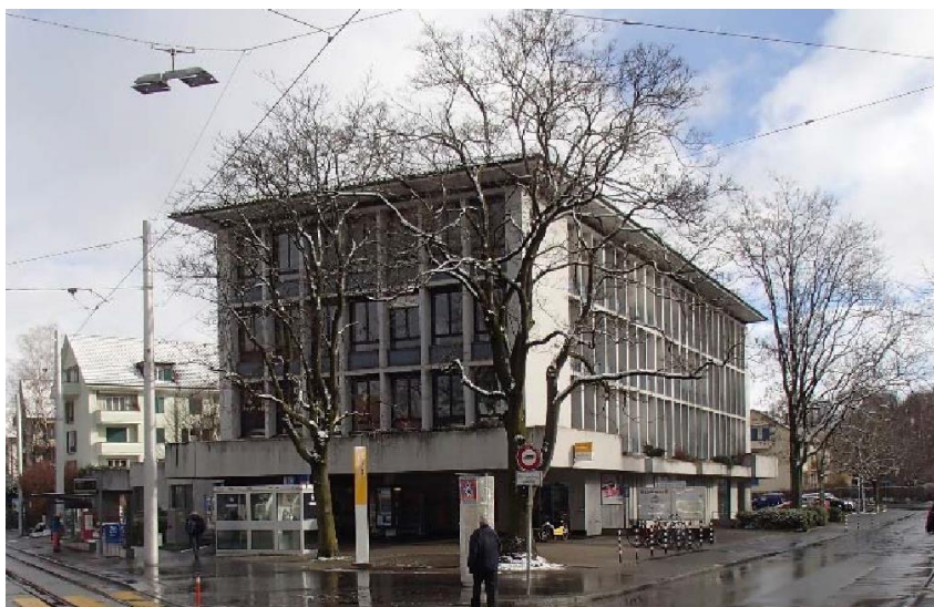
Ansicht Nord-West / Süd-West mit Hauptzugang Poststelle
