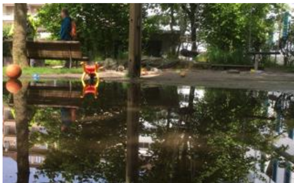
Abb. 6 und 7: Schlechte Sickerfähigkeit führt zu grossen Pfützen
