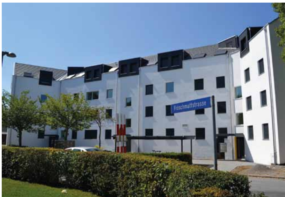
An der Fröschmatt- und Zypressenstrasse ist nach der Sanierung von städtischen Liegenschaften hindernisfreier Wohnraum entstanden.
