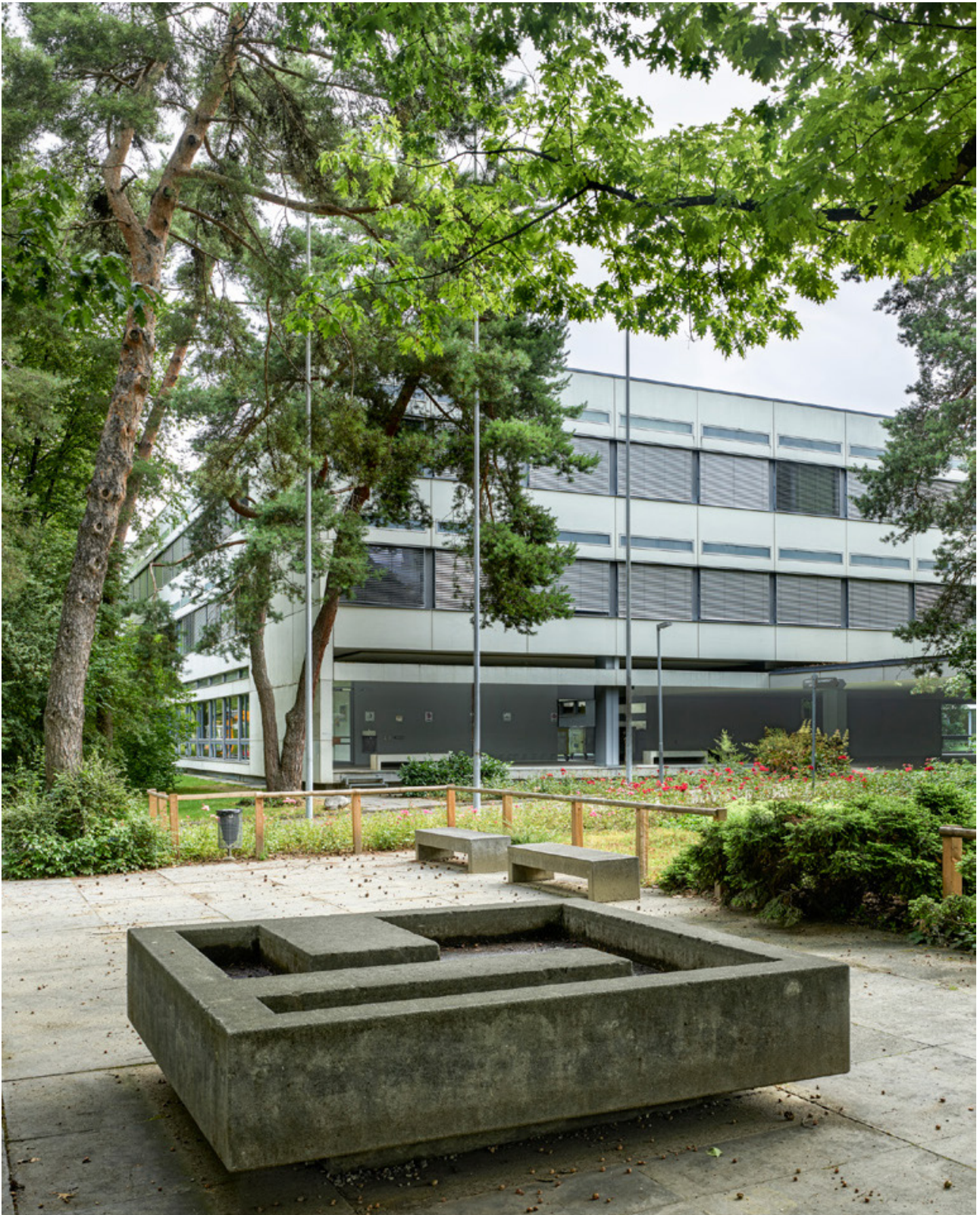
Fassade und Umgebung Schulhaus 2
