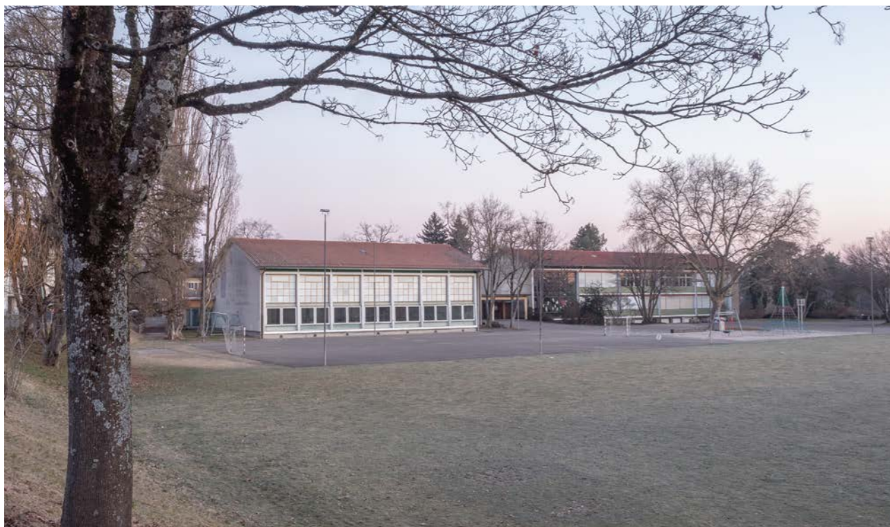
Schulanlage mit Umgebung
