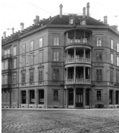
Hirschengraben mit Pflasterung im Fahrbereich
