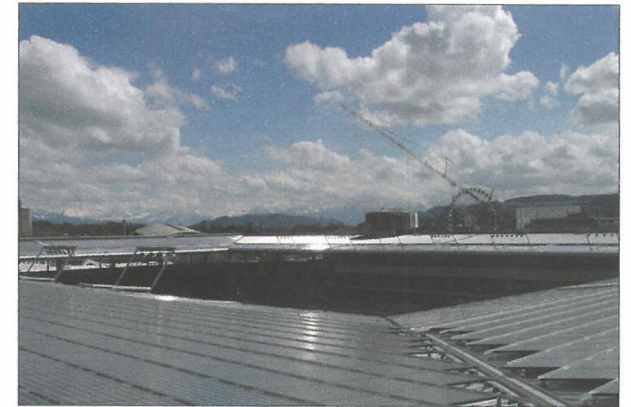
Die Solaranlage auf dem Stade de Suisse als Zeichen des ökologischen Umbaus
