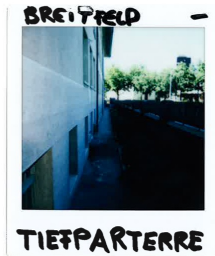
Das Tiefparterre an der Ostfassade des Gebäudes könnte gemäss der befragten Jugendlichen attraktiver genutzt werden.
